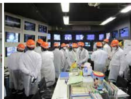
監視・制御室
