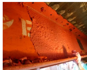
写真 橋梁塗膜除去工事の状況
