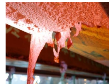
写真 橋梁塗膜除去工事の状況
