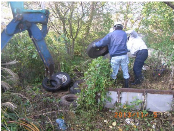
この地区では重機を使ってタイヤの撤去
